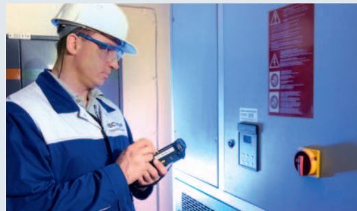
KLIMAAANLAGENWARTUNG IN ECHTZEIT: Ein TECTRION-Mitarbeiter dokumentiert alle Daten via PDA, damit sie sofort für den Kunden verfügbar sind
