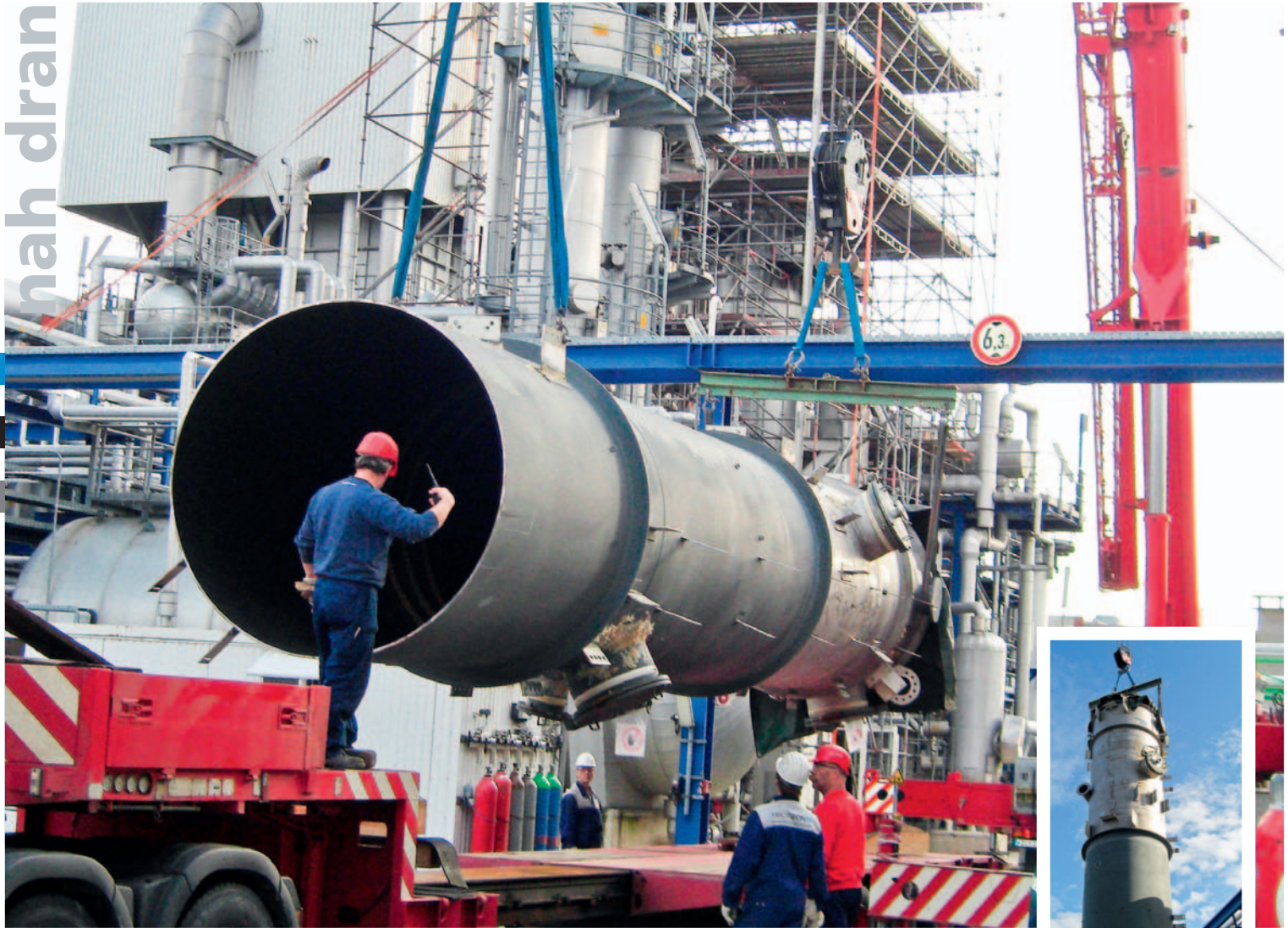
EIN KRAN befördert das neue Mantelstück in die richtige Einbauposition
