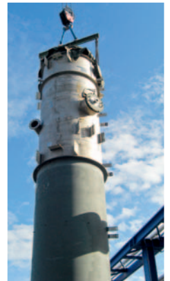
EIN KRAN befördert das neue Mantelstück in die richtige Einbauposition
