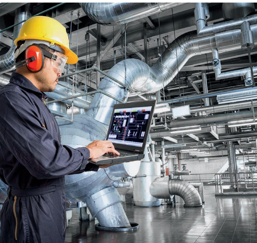
Ob Industrieanlagen, Krane, Aufzüge, Pumpen, Motoren oder Fahrräder: Tectrion kümmert sich professionell um Wartung und Instandhaltung.
